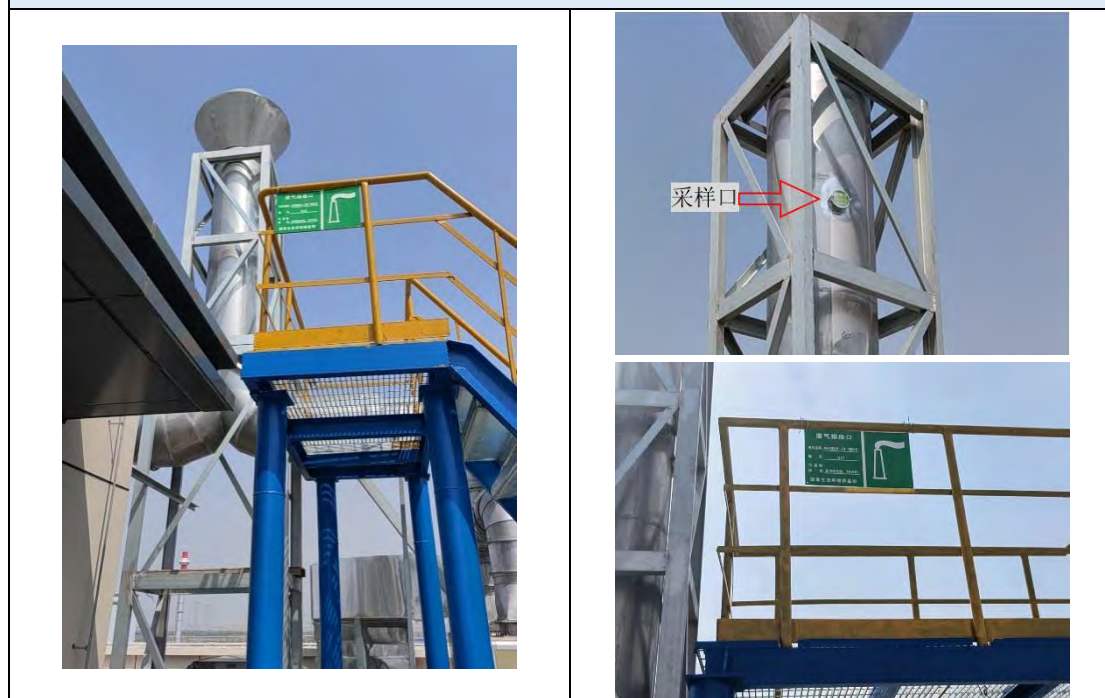
9、P 12-2 中心化验室废气 2#（采样平台、采样口、标识牌）
