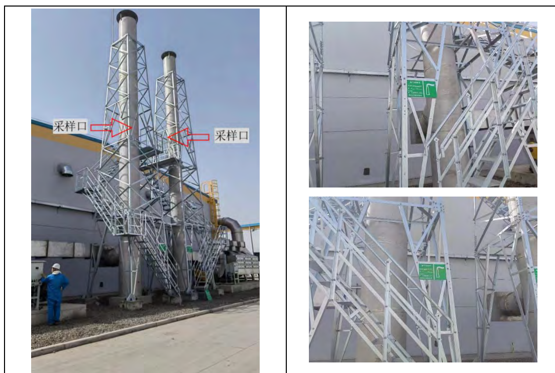
8、P 12-1 中心化验室废气 1#（采样平台、采样口、标识牌）
